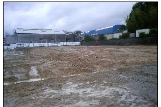
旭前町新田洞の新給食センター建設地にて
